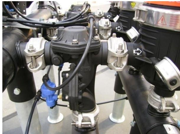
El innovador diseño de la válvula de contralavado mediante la eliminación del clásico pistón y el uso de dos membranas, da lugar a una válvula fácil de manejar, con un mínimo mantenimiento y una máxima fiabilidad.
